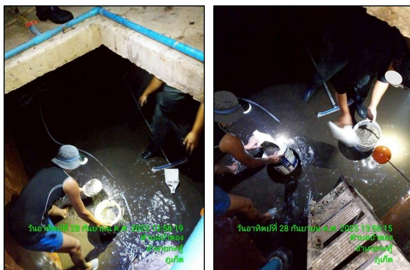
รูปภาพที่ 2.52 การล้างถังเก็บน้ำ
