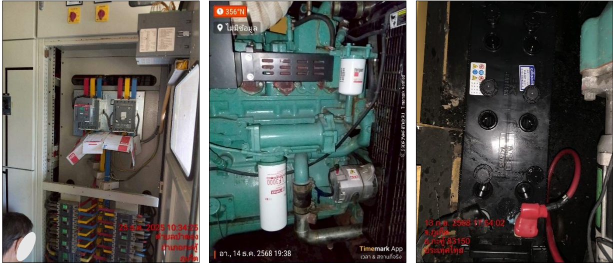
รูปภาพที่ 2.50 การตรวจสอบตู้ MDB และเครื่องกำเนิดไฟฟ้า
