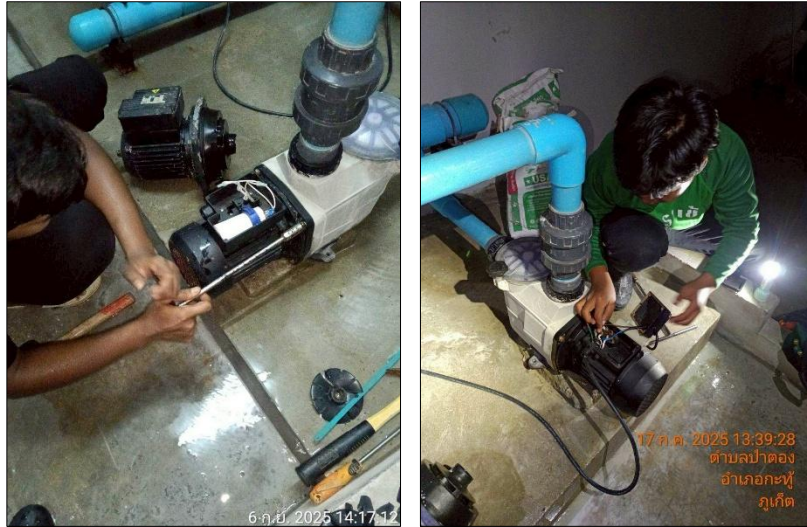
รูปภาพที่ 2.38 การล้างทำความสะอาดเครื่องกรองน้ำ (สระ)
